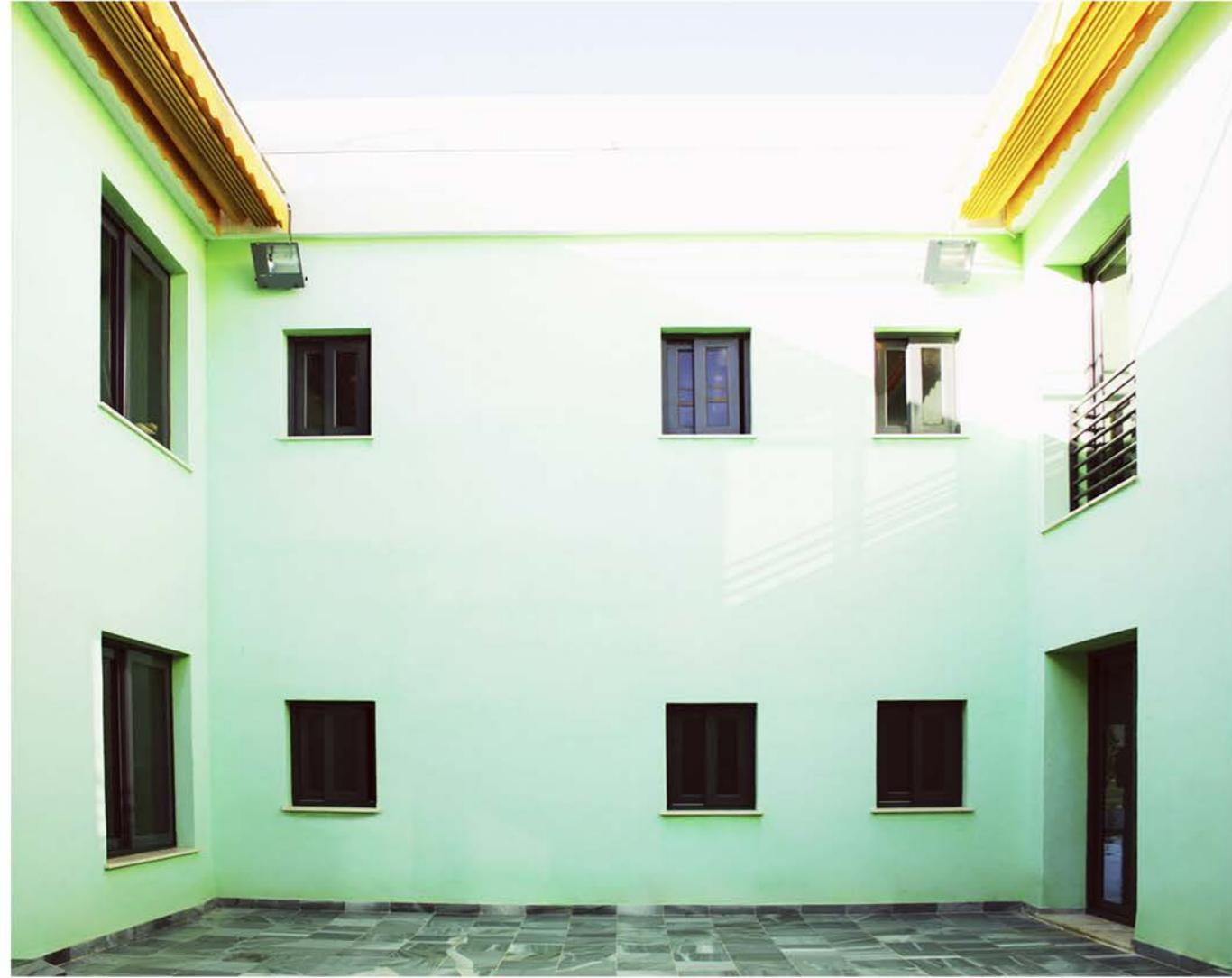
Diseño pasivo del edificio para evitar ventilaciones forzadas e iluminación artificial. (distribución de espacios en torno a un patio, sótano no enterrado, etc.) Lamas móviles y orientables conectadas a un sistema automatizado de control de la radiación solar.
